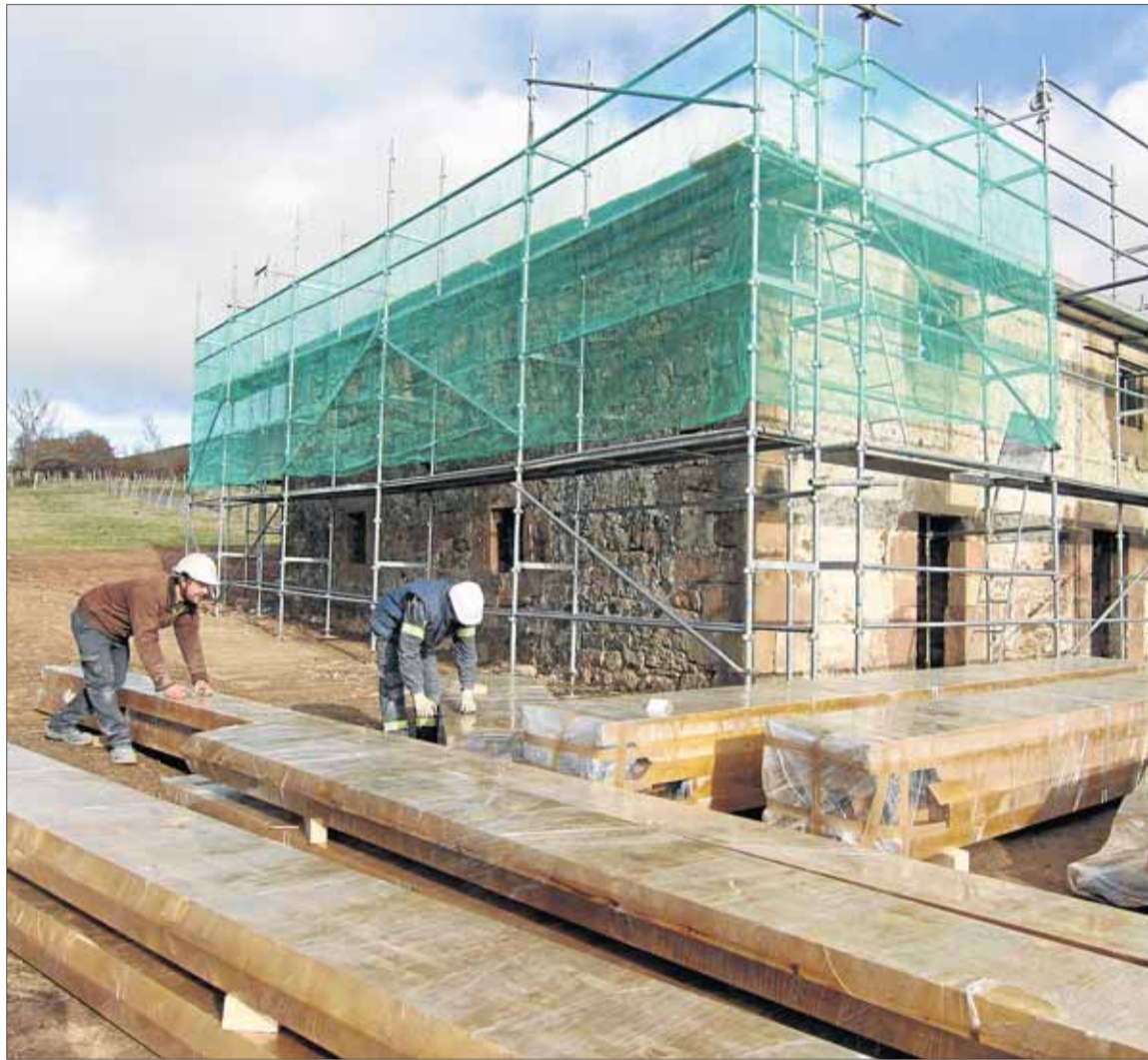
Los trabajos de rehabilitación del edificio ya han finalizado. :: J. L. SARDINA
